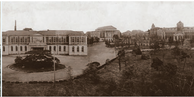
1921年頃の青山キャンパス全景 左から、新ガウチャー・ホール、大講堂(弘道館)、神学部校舎、勝田ホール
