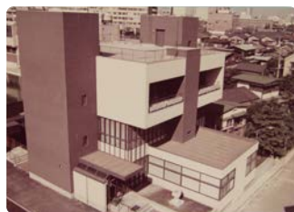
1968年竣工当時のウェスレー・ホール
