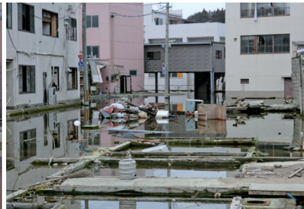
かさ上げされた道路と、港付近の街の様子(宮城県気仙沼市) 地盤沈下したため、依然として土地が海水に浸ったままであり、使用不可能な残置建造物の解体もままならない。
