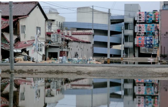
かさ上げされた道路と、港付近の街の様子(宮城県気仙沼市) 地盤沈下したため、依然として土地が海水に浸ったままであり、使用不可能な残置建造物の解体もままならない。
